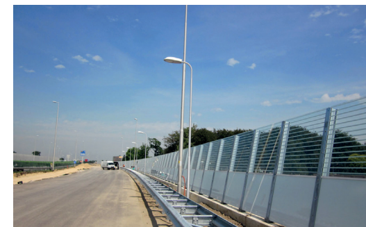
Abbildung 5.7 Kombinierte Schall- und Lichtschutzwände, welche beim Bau einer neuen Autobahn in den Niederlanden installiert wurden, um eine störende Lichtausbreitung in eine Ausgleichsfläche mit Fledermauslebensräumen zu vermeiden (© V. LOEHR).
